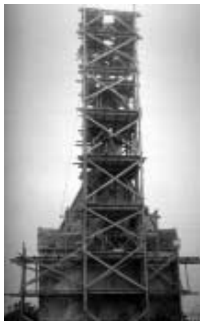
Der 1909 im Zuge der ersten groß angelegten Renovierung (Foto links) abgetragene und neu errichtete Turm der Spitalkirche ist instabil und wird derzeit saniert.
