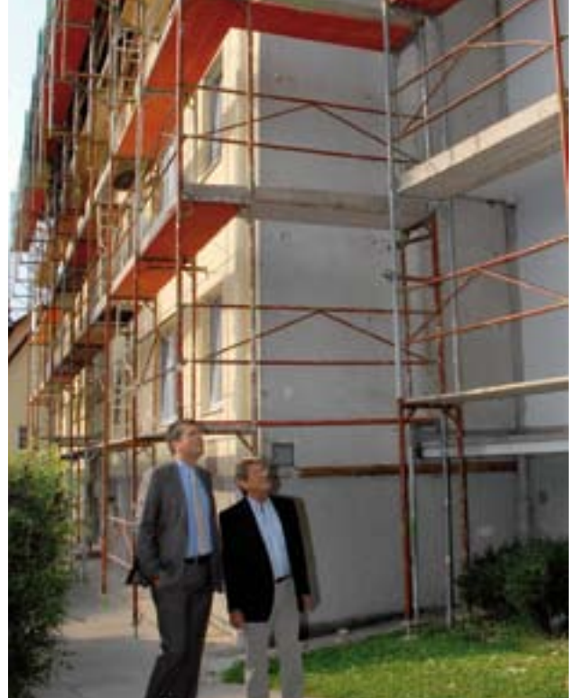
Sanierung der Wohnhausanlage Salitergasse: BGM Martin Schuster und Gf. Gemeinderat Rudolf Tlaskal beim Lokalausgleich.
