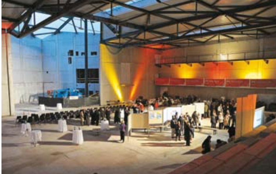
Blick von der Zuschauertribüne in die Turnhalle, dahinter (noch ohne Eindeckung) das Kletterzentrum im Rohbau.
